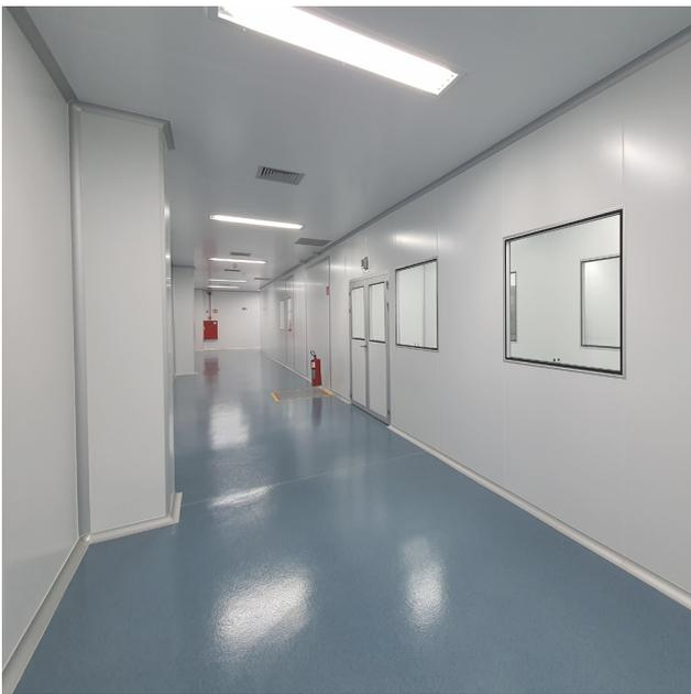
Dependendo da aplicação pode-se empregar estes isopainéis com espessuras de 50mm, 70mm ou 100mm. Em algumas situações, o processo realizado dentro das salas limpas requer que as divisórias sejam revestidas com chapa de aço inox AISI 304, para garantir a vida útil do ambiente.
