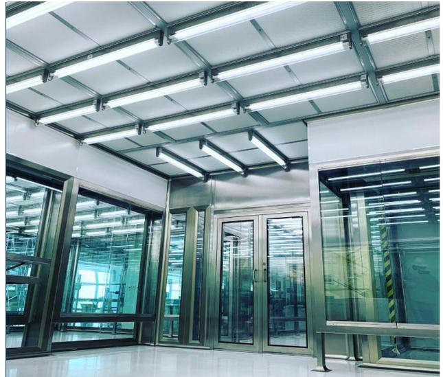
As divisórias vítreas são montadas utilizando-se vidros simples de 10mm temperado ou laminado. As divisórias vítreas permitem uma ampla visualização de todo o processo.
